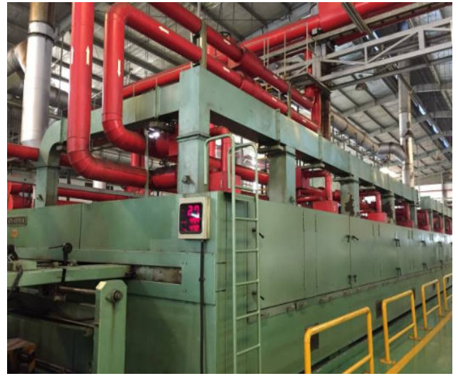
Công đoạn căng và định hình khổ vải
